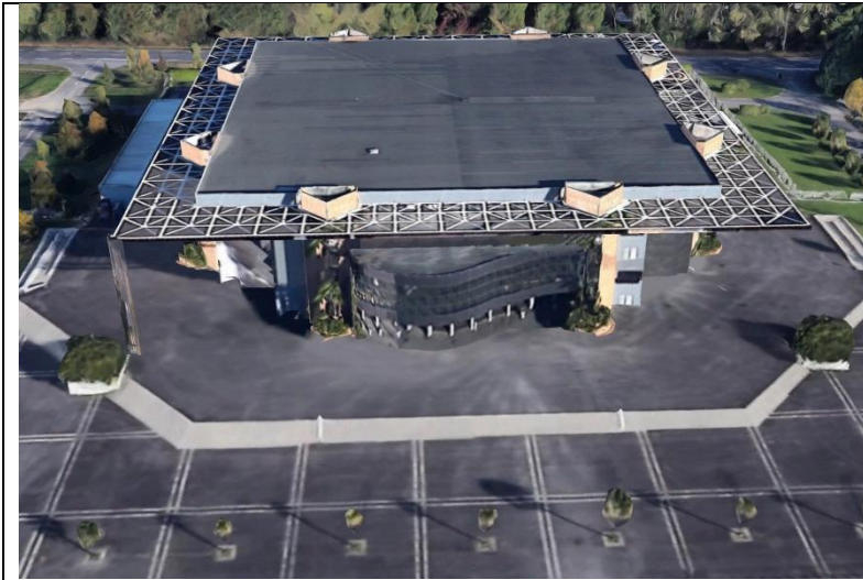
Vue sud du zénith : entrée
